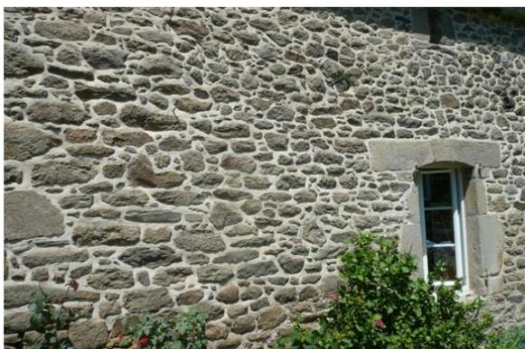
*Exemple de joints extérieurs chaux/sable*
